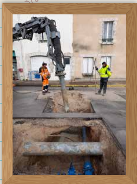
Renouvellement du réseau d'eau potable rue du Bailli
