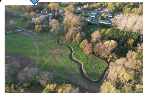
Restauration de la continuité écologique au moulin de Moquesouris, à Nazelles-Négron
