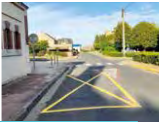
Création d'une place de stationnement pour les livraisons à la cantine scolaire.
