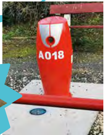
Réfection des bornes incendie.
