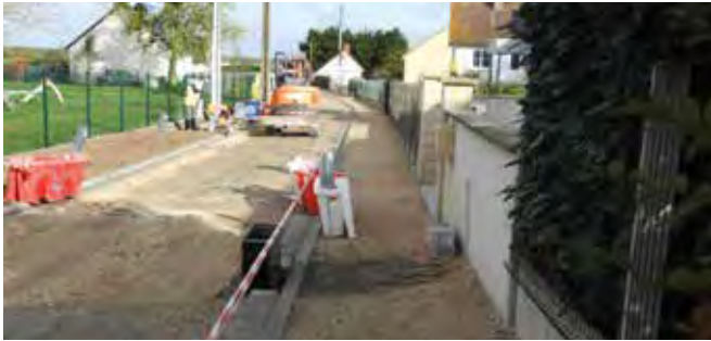
Travaux rue du Moulin à Vent.
